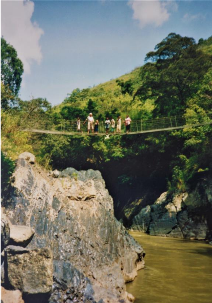
Hängebrücke in Papua- Neuguinea, erbaut von Norbert Borkenhagen
